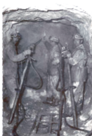
Fig.4 - Miniera di Novazza (BG) – anni '60. Fronte di avanzamento con i primi martelli pneumatici con servosostegno. Foto: D. Ravagnani.
