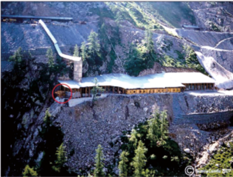
Fig. 2 - Cantiere logistico della miniera di Val Vedello. Località La Foppa, Estate 1978. Quota 1940 metri. - La grande struttura in acciaio protetta da una copertura metallica ospitava numerosi prefabbricati. La torre coperta permetteva l'accesso diretto agli imbocchi delle gallerie in ogni condizione climatica. Nel cerchio in rosso la stazione di arrivo della funivia lunga 1075 metri. Sul piazzale a dx, sopra le gabbionate il ripiano che fungeva da eliporto in inverno.
